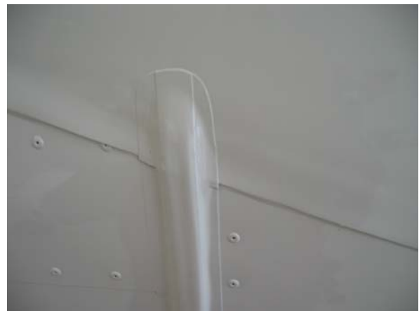
Copertura con nastro adesivo Tape cover
